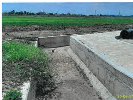
รางระบายน้ำฝน และบ่อน้ำฝนแห่งที่ 1
