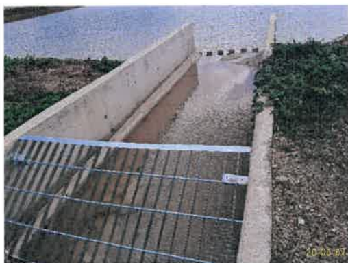
รางระบายน้ำฝน และบ่อน้ำฝนแห่งที่ 2 ภาพที่ 2.2-11 (ต่อ) รางระบายน้ำฝน และบ่อน้ำฝน
